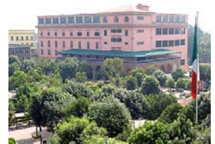
3 Edificio Centro Estudiantil Instalación MEC, Cómputos Distritales
